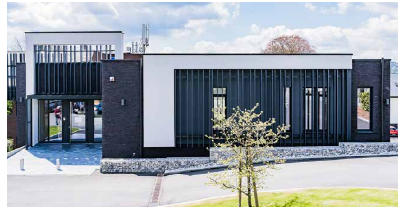
Rénovation du bâtiment abritant les bureaux de Sudinfo à Namur.
