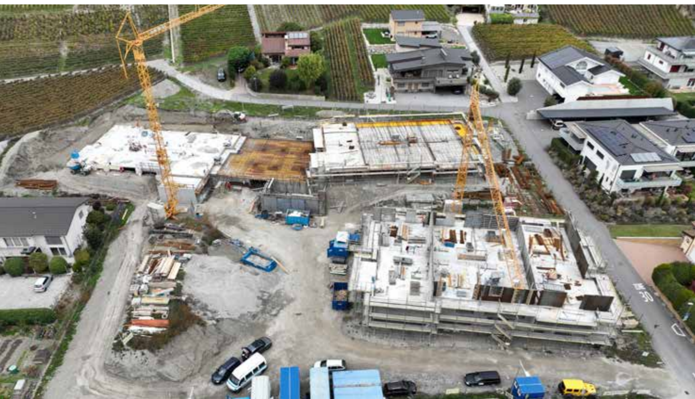
Construction de trois immeubles à Leytron (projet La Salentze, Suisse).
