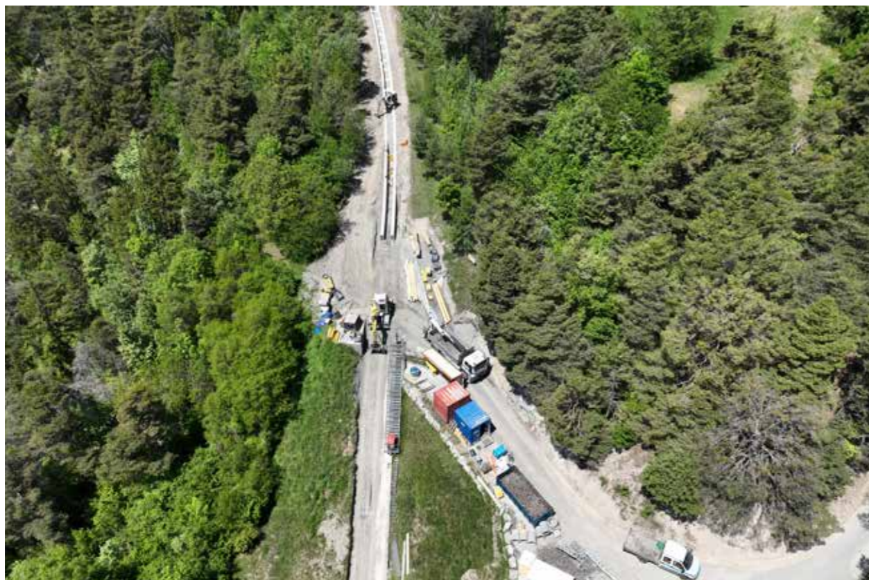
Reconstruction de la ligne SMC à Crans-Montana.
